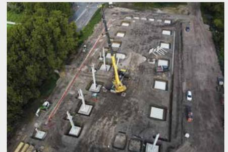
Die Fertigteilstützen werden gesetzt.
