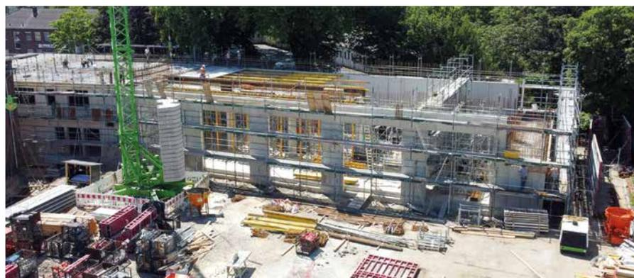
Rohbau des Erweiterungsneubaus der Feuerwache 9. Auf dem Bild zu erkennen sind der bis zum 1. OG fertiggestellte Sozialtrakt (links) sowie der Rohbau der Fahrzeughalle (rechts), in welcher zu diesem Zeitpunkt das Traggerüst zur Bauunterstützung der Halffertigteildecke montiert wird.
