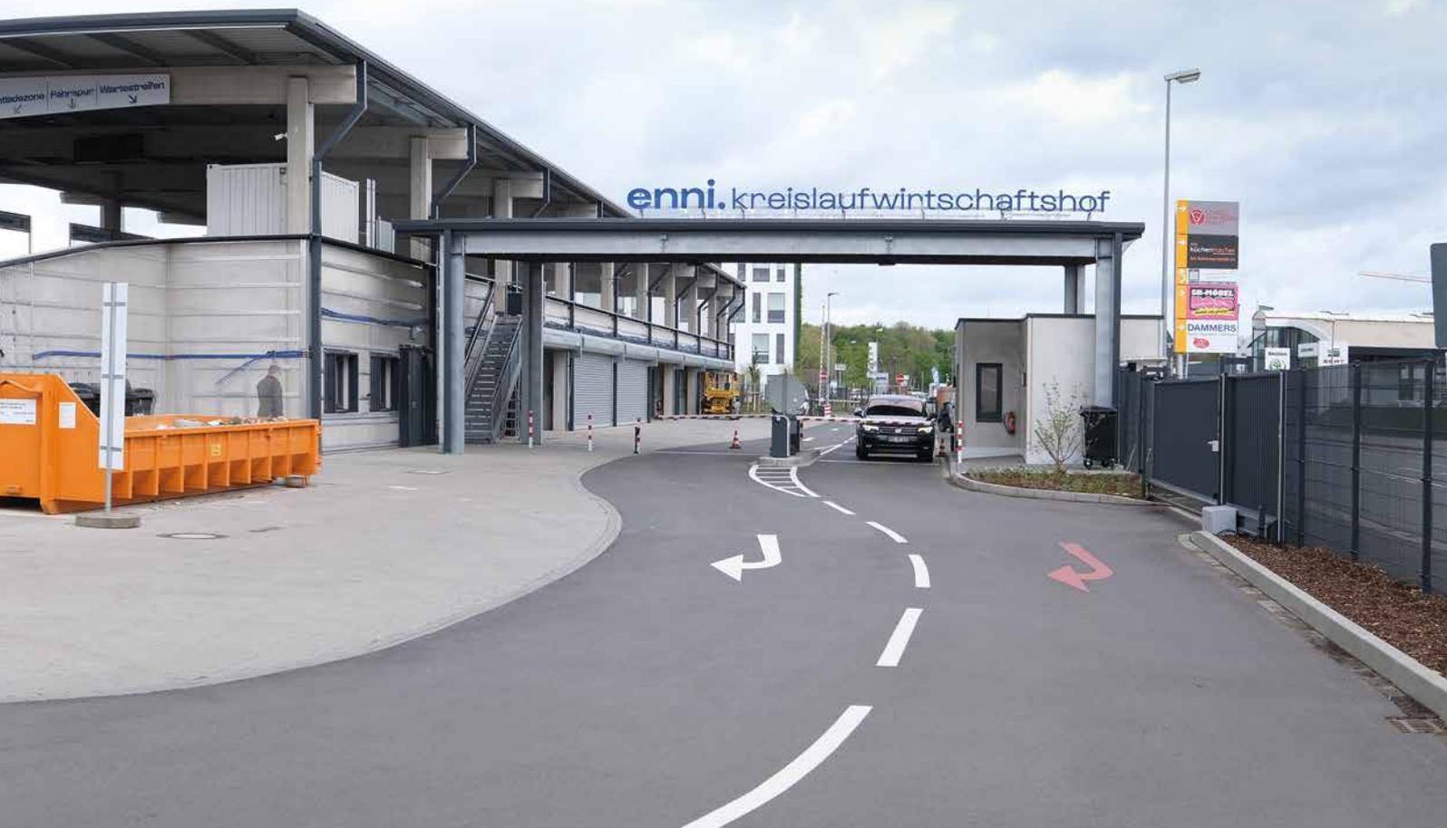
erforderlich. Der befahrene Gebäudebereich erhielt eine Gussasphaltdecke, die für eine zusätzliche Abdichtung sorgt. Drei Stahlbaukonstruktionen dienen als Überdachung im Außenbereich. Auch diverse Schlosserarbeiten wie Geländer, Treppen und Rutschen zur Entsorgung von Altpapier gehörten zum Leistungsspektrum von Hundhausen. Seinem Motto wird der neue zweigeschossige
