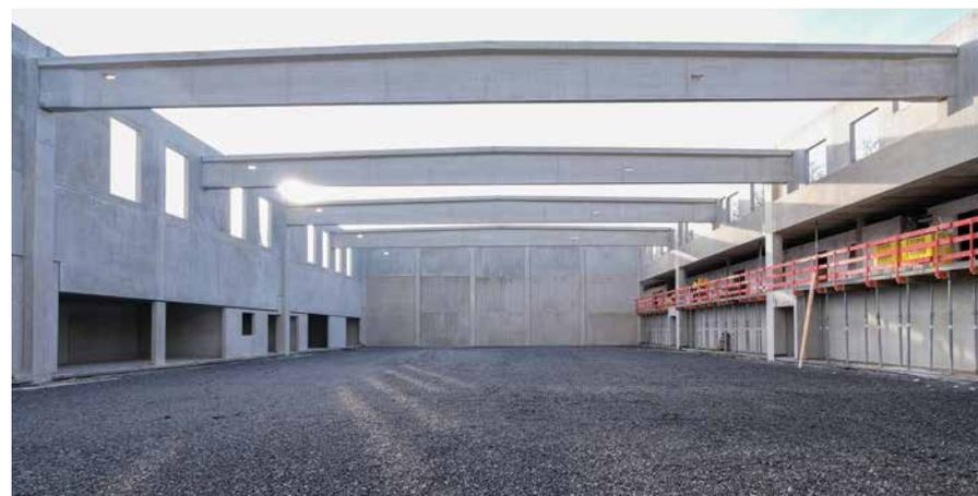
Innenansicht des Rohbaus der ersten Dreifach-Sporthalle mit Stahlbeton-Fertigteilen
