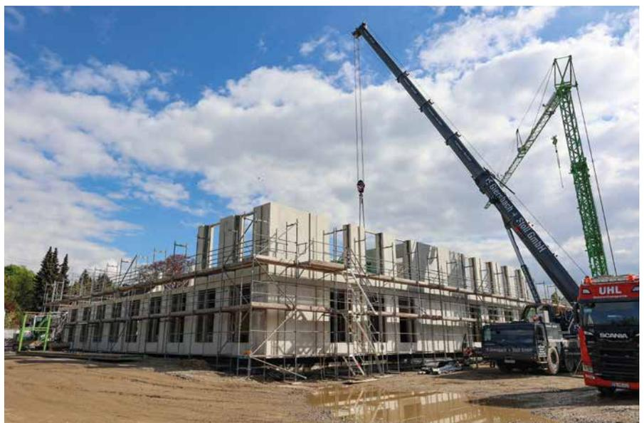
Das Untergeschoss der neuen Hauptverwaltung ist fertig, die Fertigteile für das Obergeschoss werden montiert.
