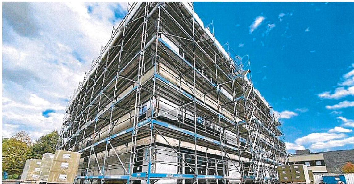
Ein neues Gebäude am Ernst-Mach-Gymnasium nimmt sichtbare Formen an. Im nächsten April soll Bauteil C fertig sein.
