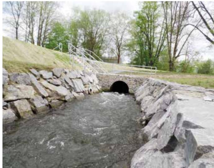
▲ Neugestalteter Mühlgrabenauslauf in Natursteingewölbe mit beidseitigem Steinsatz und Übergang des neuen Dammbauwerkes
