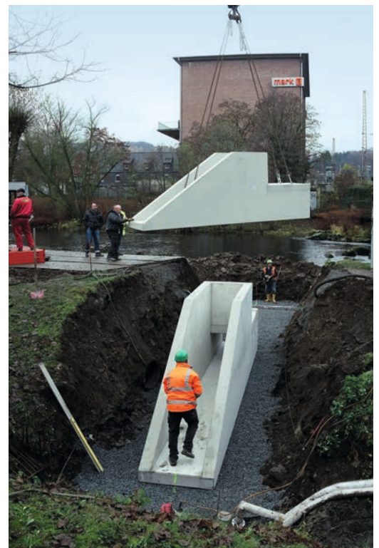
Montage der Fertigteile für den Durchstich-Graben ▶
