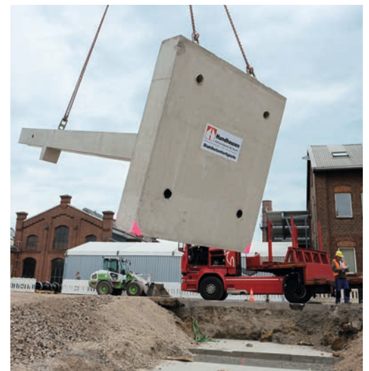
▼ Stütze mit angeformtem Fundament aus dem Siegener Fertigteilwerk für die neue Lagerhalle
