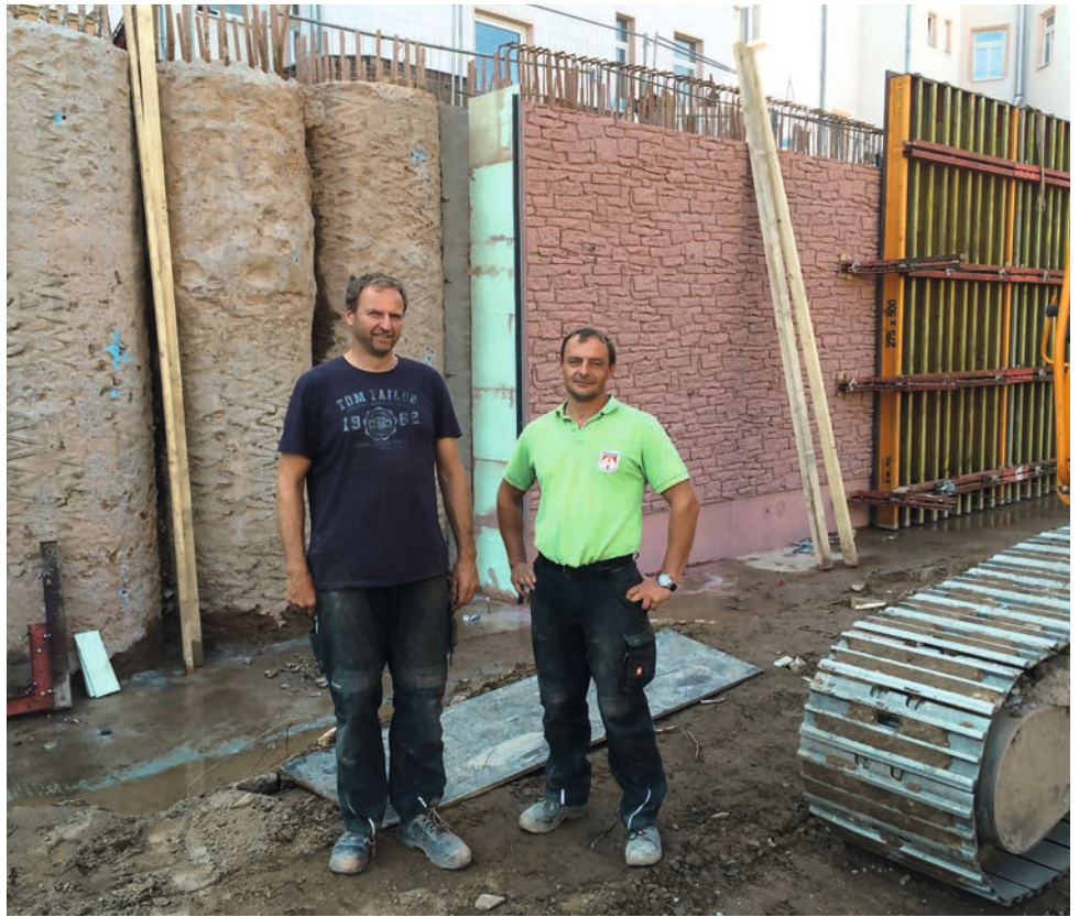
▲ (v. l.) Jörg Schreiter und Falko Groß vor der Bohrpfahlwand und der betonierten Vorsatzschale mit Strukturmatrize
