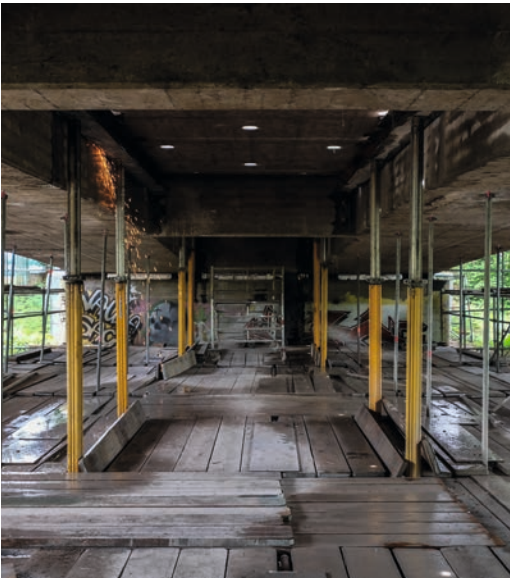
▼ Durch den Einsatz von Fertigteilen wächst die neue Brückenfahrbahn schnell zusammen.
