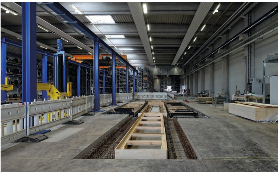
▼ Fundament für die Waschanlage der Radsätze
