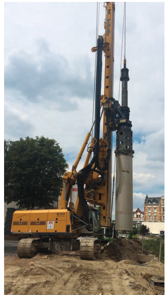
▲ Bohrergerät für Groß-Bohrpfähle, Durchmesser 1,20 m, bis 20 m Länge
