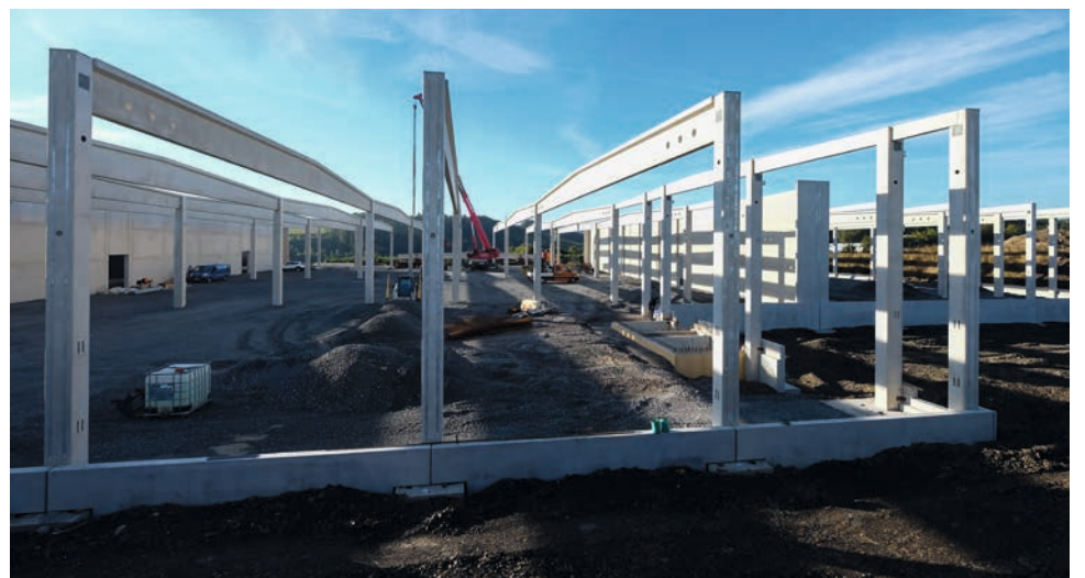
▼ Filigrane Fertigteilkonstruktion mit 27 m langen Spannbeton-Bindern
