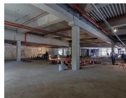
▲ Der Innenausbau läuft
