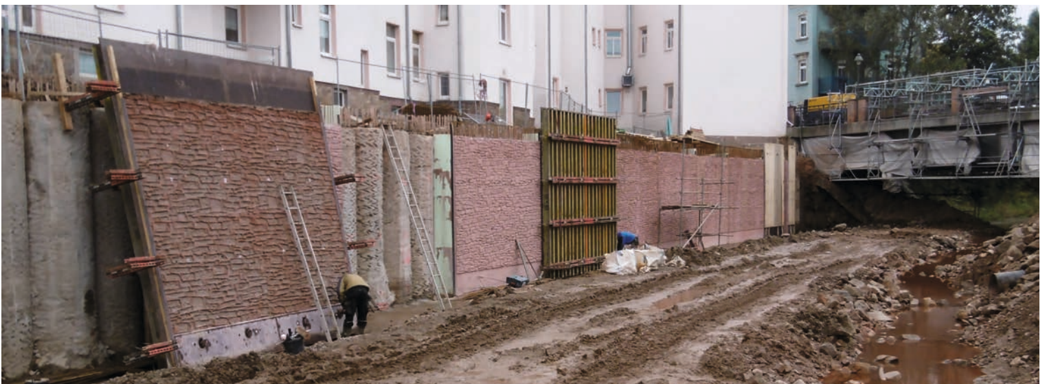
▼ Verschiedene Takte bei den Schalarbeiten für die neue Schutzwand
