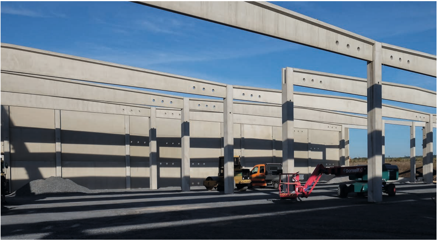
▲ Brandwandansicht mit vorgelagerter Hallenkonstruktion
