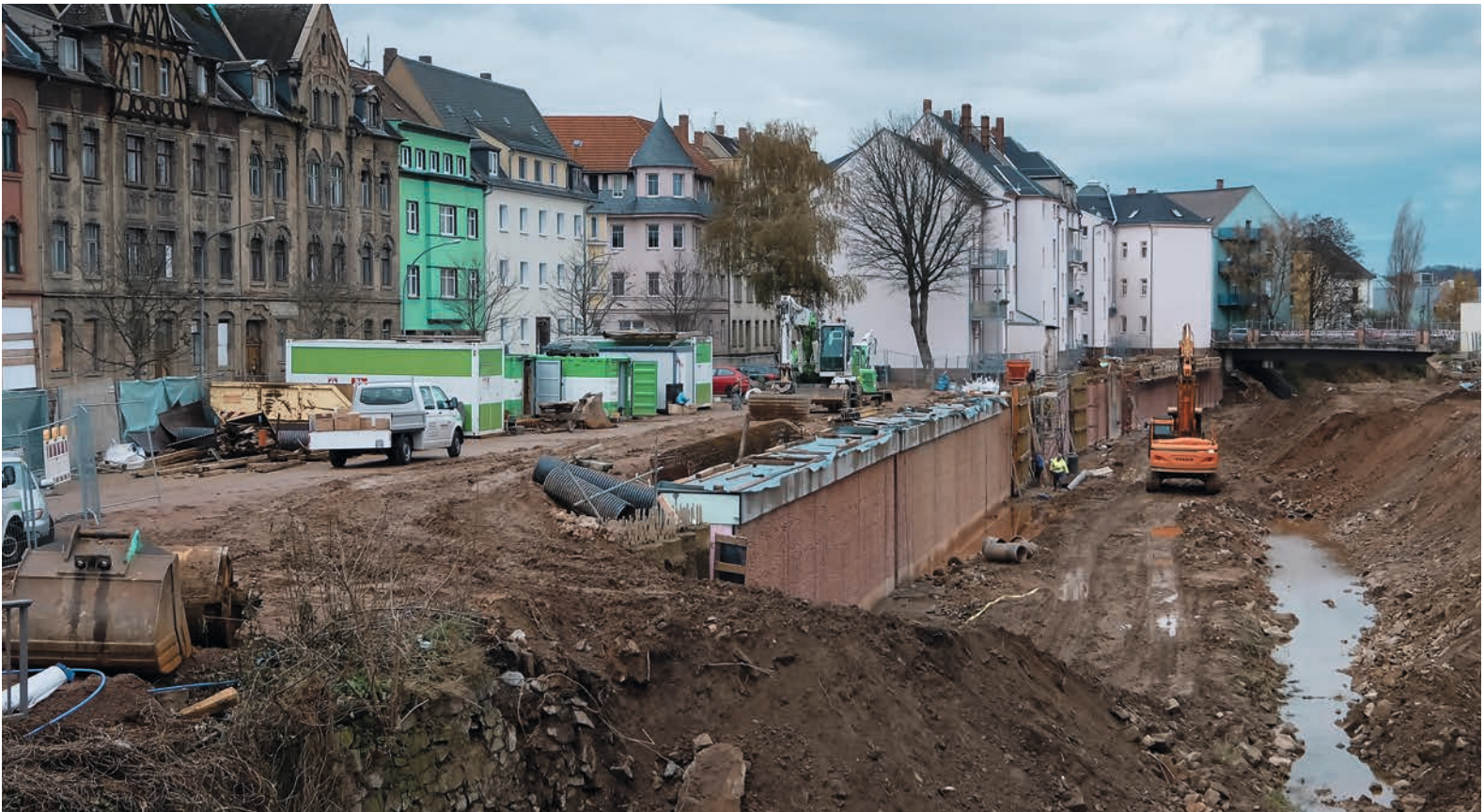
▲ Gesamt-Ansicht der Hochwasserschutz-Maßnahme „Flutmulde Döbeln“
