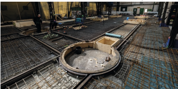
▼ Umbau im Bestand – Hubdrehscheibe mit Gleisen für Achsentransport
