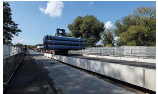
▼ Die fertiggestellte Brückenfahrbahn unter Vollast
