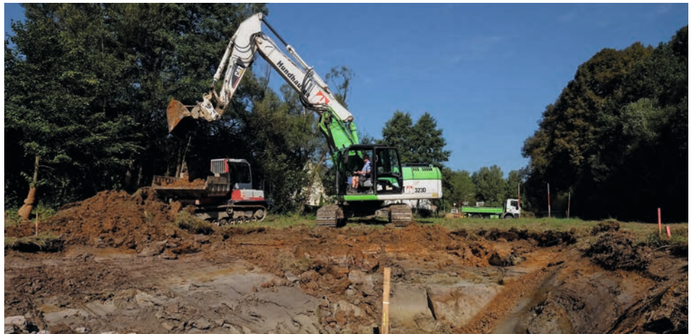
▲ Profilierung des neuen Bachlaufs
