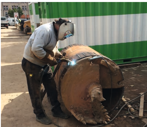
▼ Frank Lohse bei Schweißarbeiten am Kastenbohrer des Großbohrgerätes
