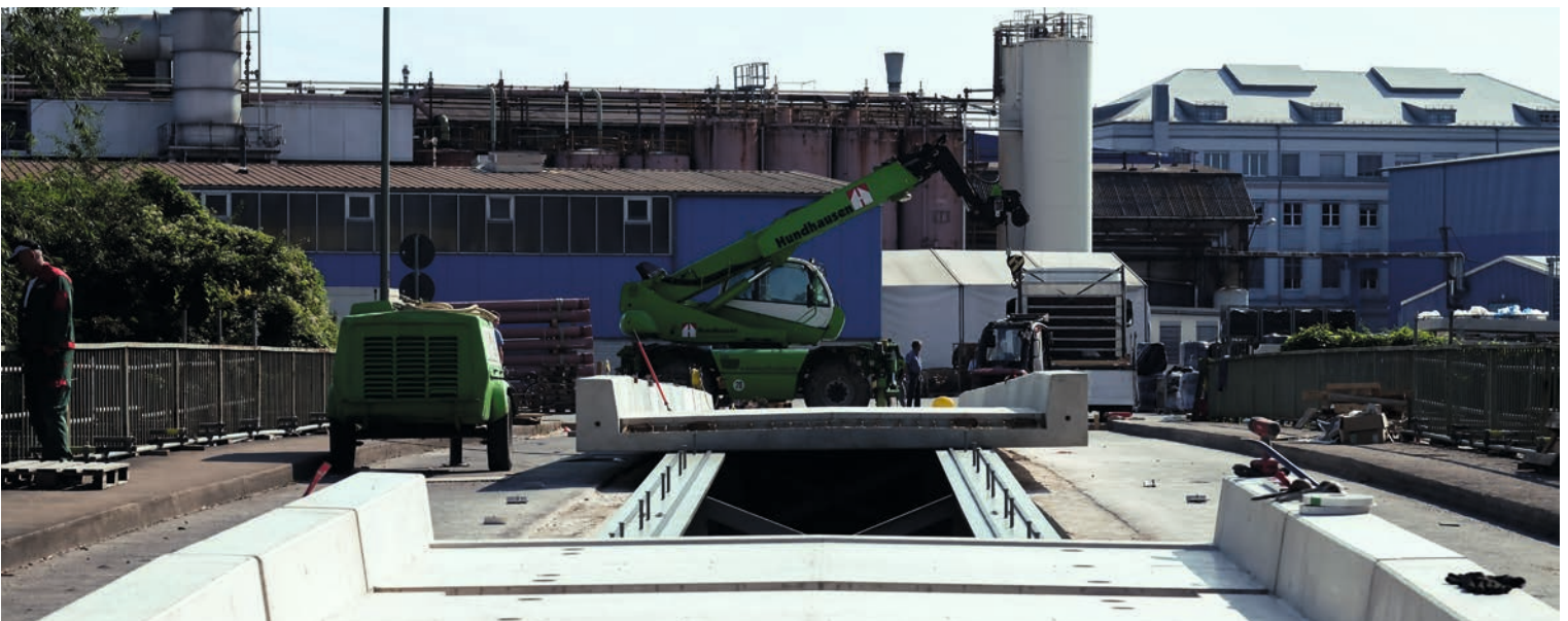
▼ Durch den Einsatz von Fertigteilen wächst die neue Brückenfahrbahn schnell zusammen.
