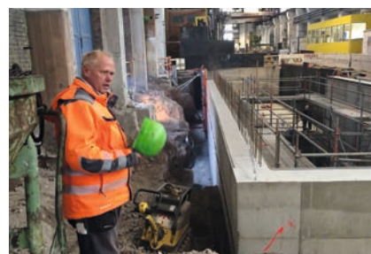
▼ Vorarbeiter Bernd Reichenbacher vor der teilbetonierten ESU-Grube
