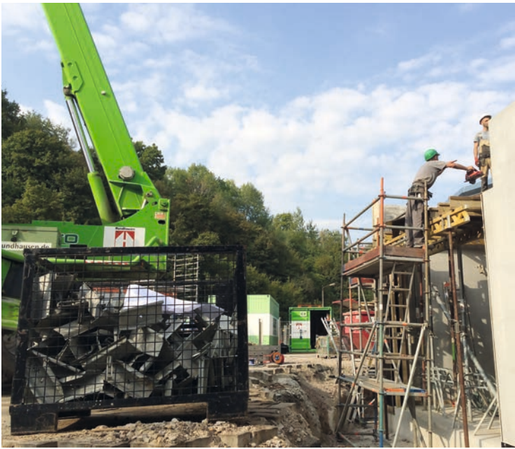
▲ Weidaer Kollegen bei der Wandmontage für das Hydraulikgebäude
