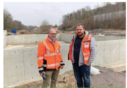
Stephan Hundhausen und Benjamin Schneider bei einer Baustellenbegehung
