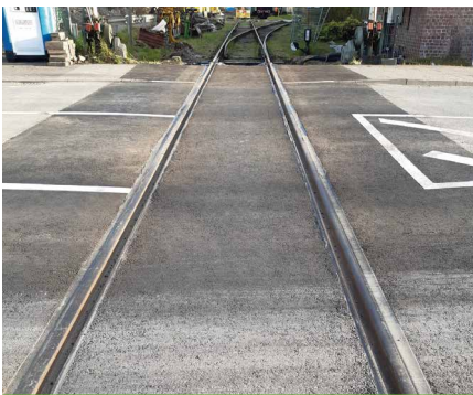
Der Bahnübergang ist nun auf das erhöhte Verkehrsaufkommen bestens vorbereitet.
