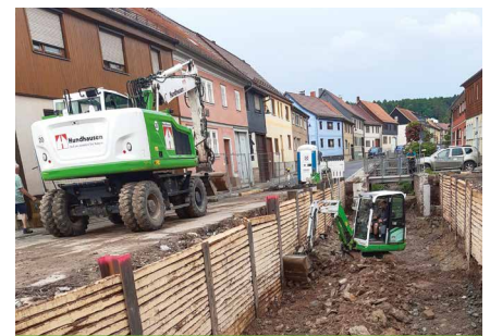
Herstellung der Gründungssohle
