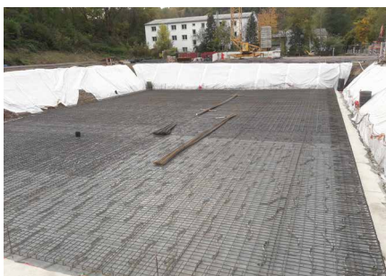
Verlegung der Sohlplattenbewehrung
