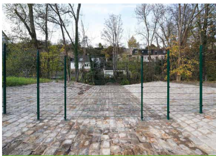
Trichter-Notüberlauf des Regenrückhaltebeckens
