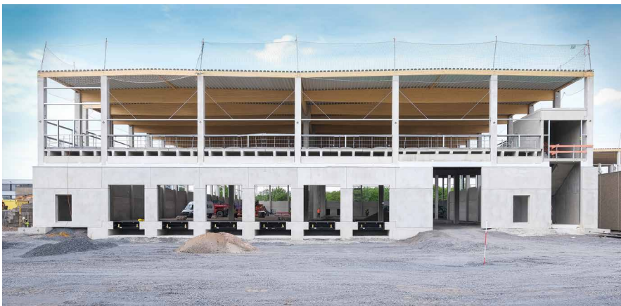
Schönes Zusammenspiel von Holz und Stahlbeton - Blick auf den Verladebereich der neuen Logistikhalle
