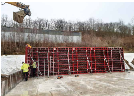
Aufstellung der Wand-Schalung
