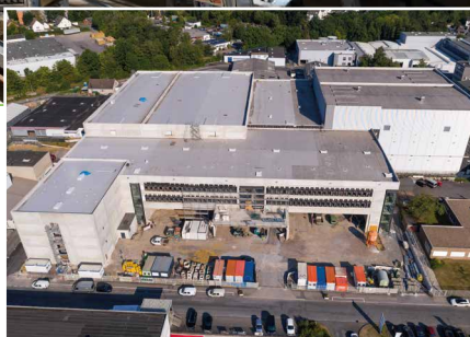
Gesamtansicht nach Fertigstellung der Lager-Rohbauten
