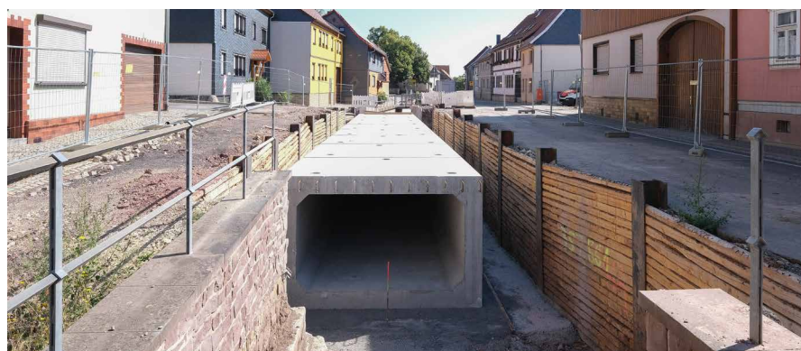
Sieben der insgesamt neun Stahlbeton-Rahmenbaufertigteile sind eingesetzt.
