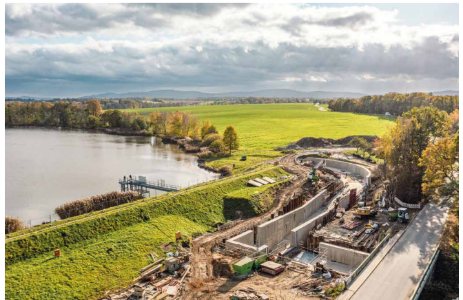
Anspruchsvolle Hochwasserentlastungsanlage in Göda, Seite 7
