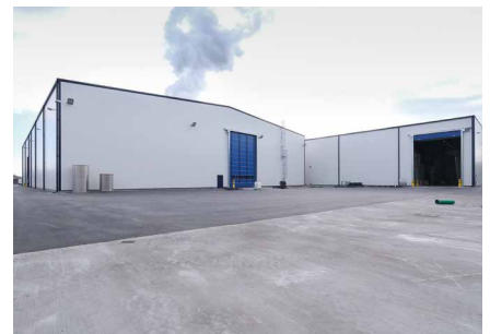
Außenansicht der fertig gestellten In- und Outputhalle
