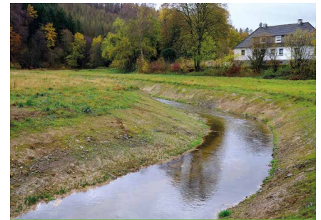
Nach Umlegung der Gewässer
