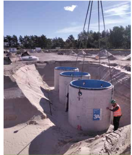
Marcel Meder beim Ausrichten der Behälter für die Abwassertechnik der Waschanlage
