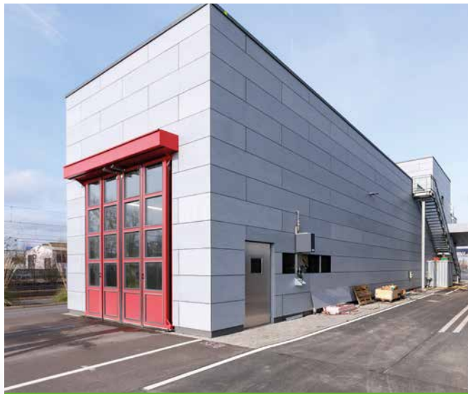
Portalwaschanlage für Elektrobusse mit integrierter Wasseraufbereitung
