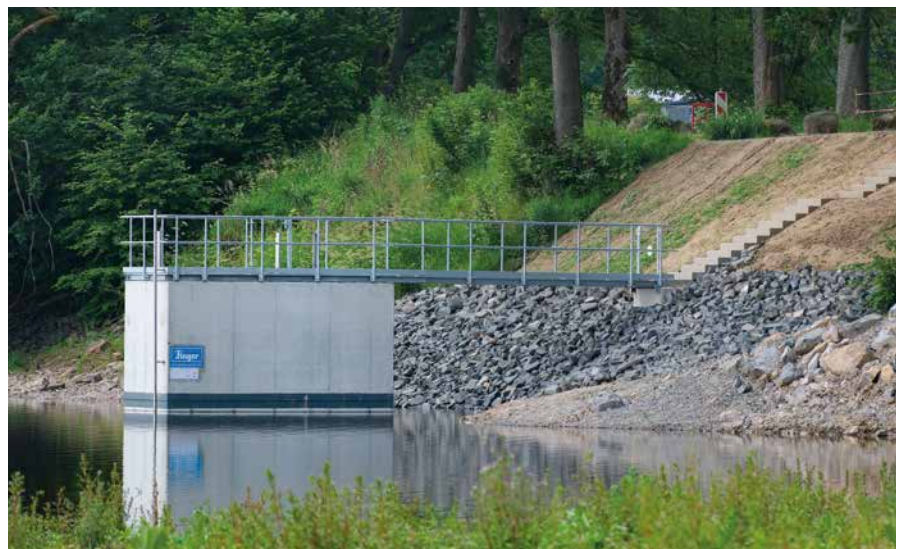
Fertiggestelltes Mönch-Bauwerk am Dreifelder Weiher
