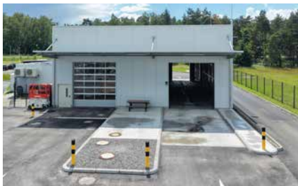
Blick auf die neue Werkstatt- und Waschhalle
