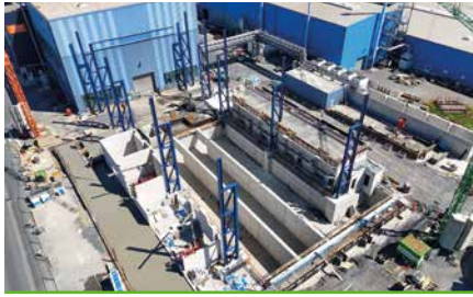
Blick auf die Gründung und den Anlagenkeller der neuen Umschmelzhalle
