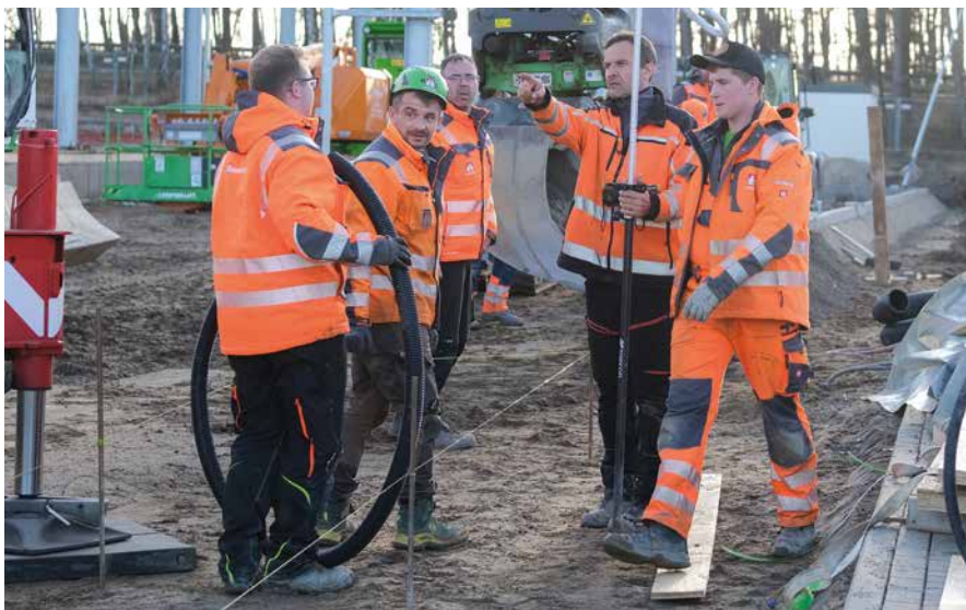
Die Baustellenteams aus Weida und Eisenach arbeiteten Hand in Hand und sorgten für die termingerechte Fertigstellung.
