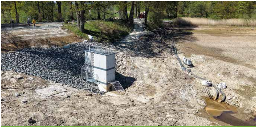
Neues Mönch-Bauwerk mit Steinschüttung nach dem Einbau
