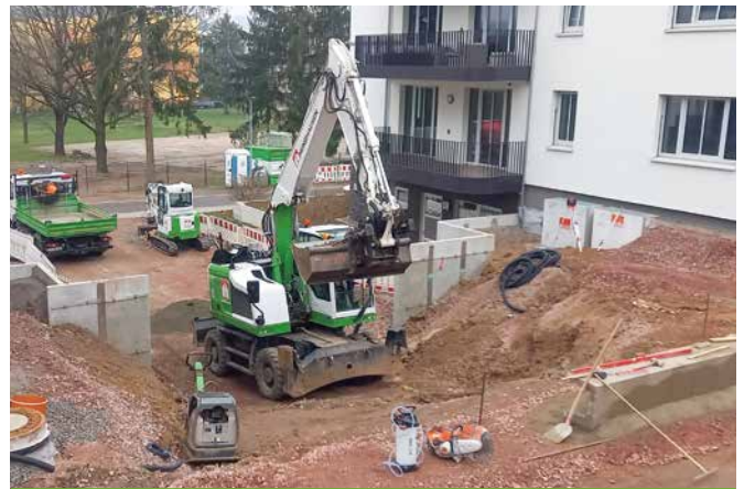
Hinterfüllung der Sitzcke mit Winkelstützwänden zur Geländesicherung
