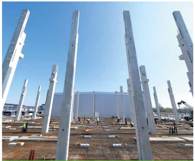
Fertigteil-Konstruktion und Bewehrung der Bodenplatte der neuen Werkstatthalle
