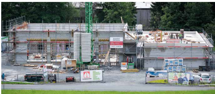
Auf der Baustelle der neuen Feuerwache schreiten Rohbau und Dacharbeiten zügig voran.
