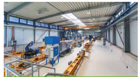
Die Langschienen werden auf einem motorisierten Rollengang durch die Halle transportiert.
