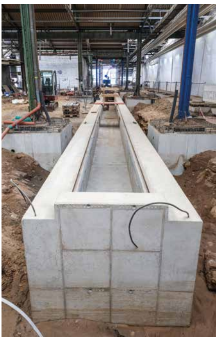
Schalungs- und Betonarbeiten der neuen Gleisgrube
