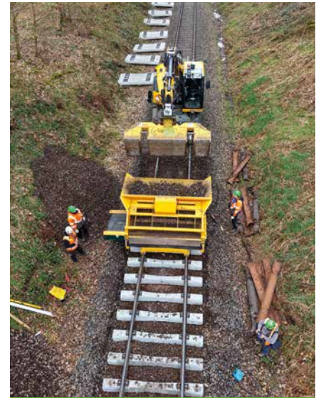
Ein weiterer Schritt zu effizientem und ressourcenschonendem Gleisbau: die neue Schotterreinigungsmaschine im Einsatz.
