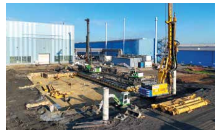
Bohrpfähle als Tiefergründung für die Fundamente und Spundwandverbau für den Anlagenkeller der neuen Umschmelzhalle
