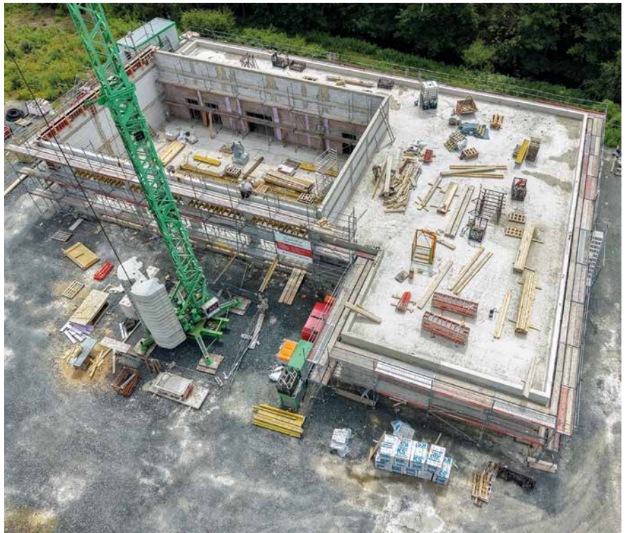
An der Landstraße zwischen Flammersbach und Anzhausen entsteht die neue Feuerwache für das Obere Weißtal.
