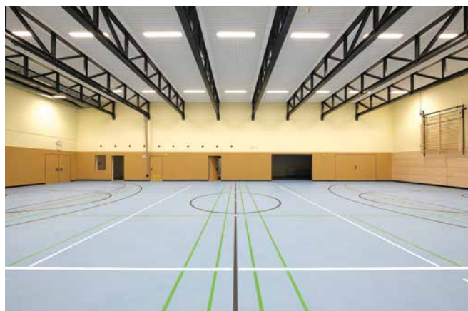
Sanierung Sporthalle in Köln, Seite 6
