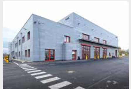
Nordansicht der Buswerkstatt mit angrenzendem Sozialtrakt
