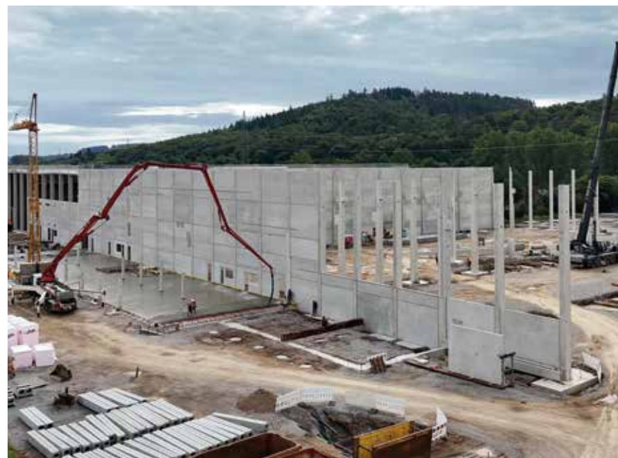
Der angeschlossene Bürotrakt wird für die Fertigteilmontage vorbereitet, parallel erfolgt die Stützenmontage in Halle 5.
