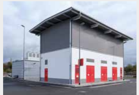
Energiezentrale und Trafo 1
