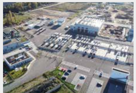
Luftaufnahme des 63.000 m 2 großen KVB-Geländes
