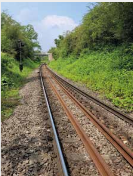
Die Gleisbau-Abteilung wechselte an Pfingsten und dem darauffolgenden Wochenende für die Häfen und Güterverkehr Köln AG die Fahrtschiene aus. Dies beinhaltete den Ausbau der alten Schiene und den Einbau der neuen Schiene inklusive Schweißungen.
