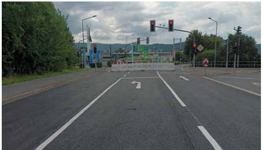
Die sanierte Kreuzung „Mühlhäuser Straße/An der Tongrube“ kurz vor der Verkehrsfreigabe
