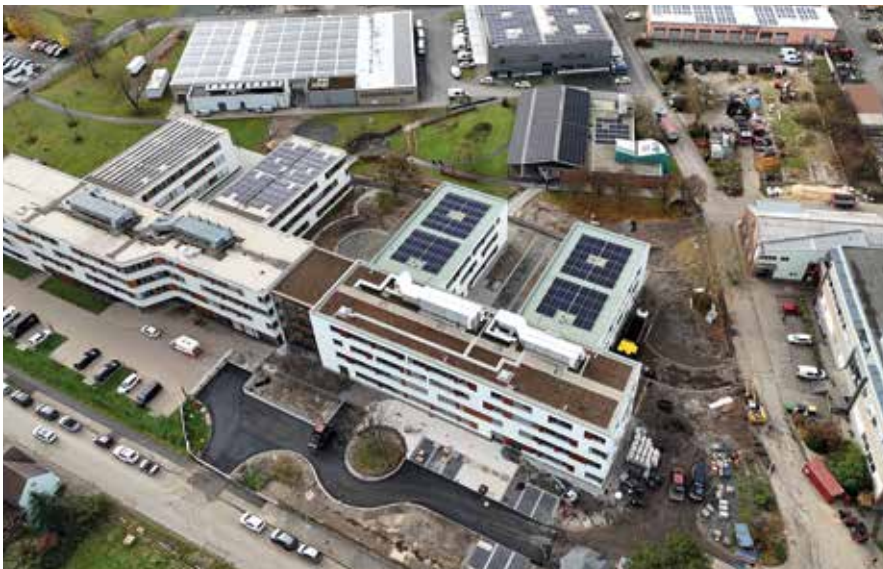
Luftbild des Neubaus - das Dach ist auf einer beeindruckenden Fläche von 1.000 m 2 begrünt.
