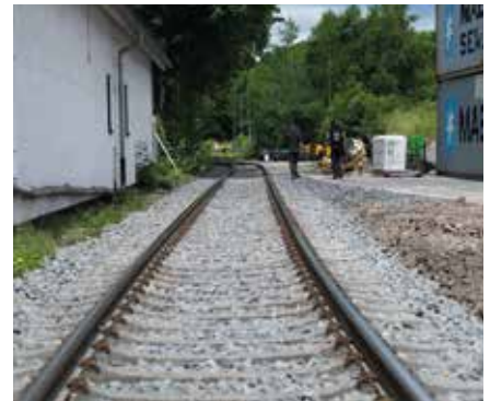
Das erneuerte Gleis, Richtung DB Anschlussgrenze
