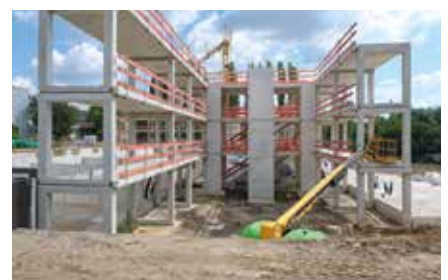
Die beiden Wohnhäuser A und B sind durch das Treppenhaus und den Aufzugschacht miteinander verbunden.
