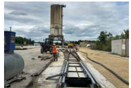
Besart Ferizi beim Einmessen der Unterflurweiche
