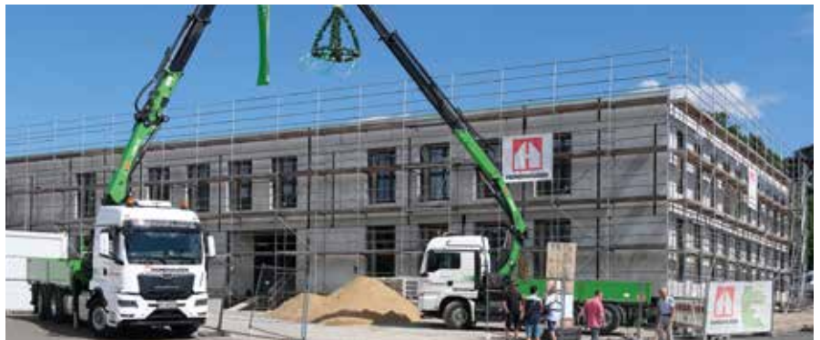
Das Richtfest des neuen Verwaltungsgebäudes in Siegen-Weidenau wurde am 16. August 2024 gefeiert!
