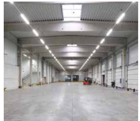
Innenansicht der neuen Umschlaghalle
