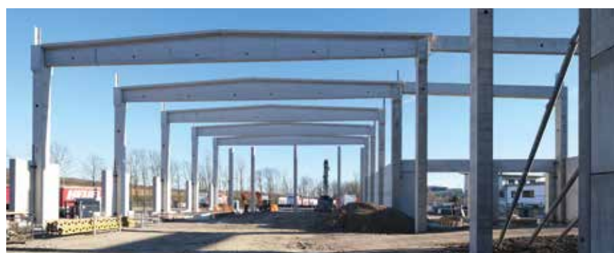
Blick auf die Stahlbeton-Fertigteil-Konstruktion der Umschlaghalle
