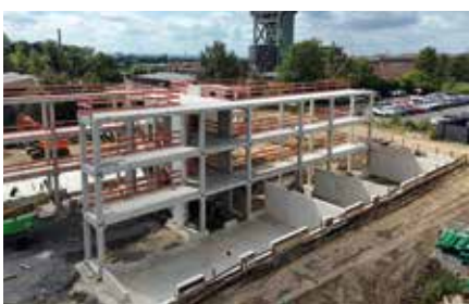
Blick auf die Laubengänge des Wohnhauses A
