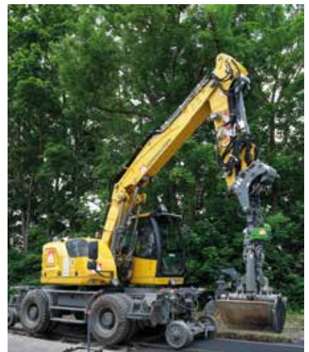
Karsten Gräbener im neuen Zweibegebagger A922 Rail beim Asphalteinbau
