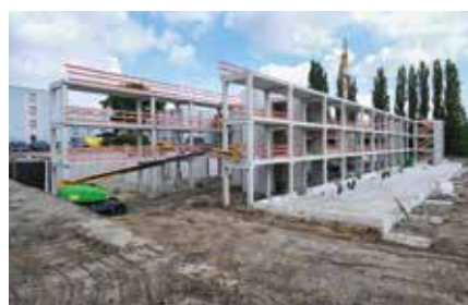
Die Laubengänge sind montiert und die Balkongründungen sind vorbereitet.
