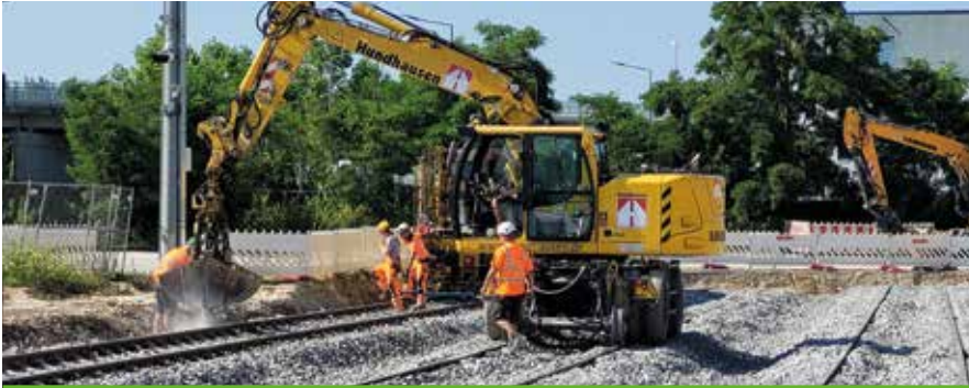
Gleisbaukolonne um Polier Sebastian Kemper beim Einschottern und Stopfen der Gleise
