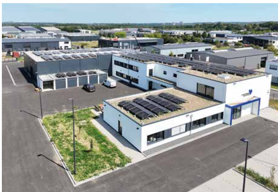
Gesamtaufnahme des neuen Verwaltungsgebäudes und der Lagerhalle
