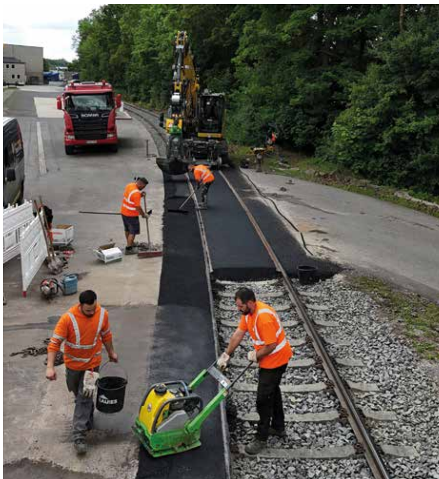
(v. l.) Nadim Samo, Besart Ferizi, Amjad Alabdurahman und Alwin Weber bauen den Asphalt ein.
