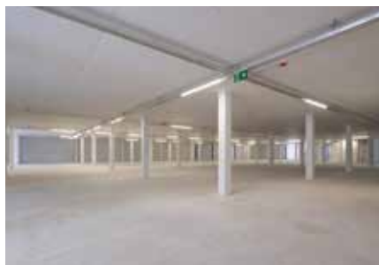
Das 4. OG ist noch nicht mit Lagerboxen ausgestattet und dient zurzeit noch als „Pufferzone“.
