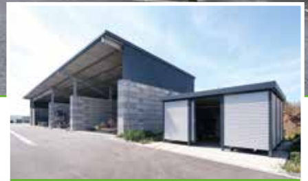
Außenlager der Stadtwerke Erfstadt
