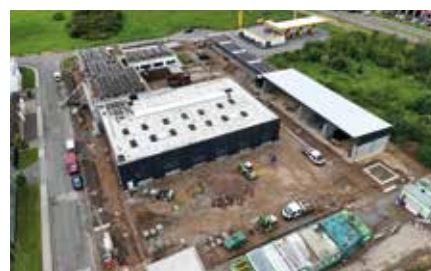
Gesamtkomplex mit Außenbereichen (Bauzustand vor Erstellung der Außenanlagen)
