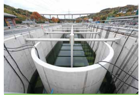
Blick in die zweite Beckenkammer des neuen Belebungsbeckens 4
