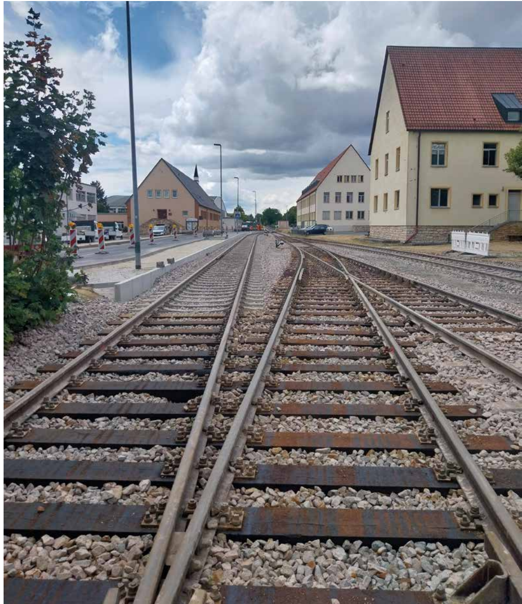
Im Vordergrund liegen zwei der neu besohnten Weichen, links ist der neue Gehweg mit der Winkelstützmauer zu sehen. Rechts entsteht später einer der neuen Fußgängerüberwege, der die drei Gleise mit dem Gehweg verbindet.
