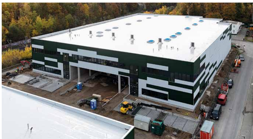
Die insgesamt 120 Stahlbeton-Fertigteile von Hundhausen sind hinter der montierten Fassadenkonstruktion vollständig verborgen und prägen dennoch maßgeblich die Tragstruktur des Gebäudes
