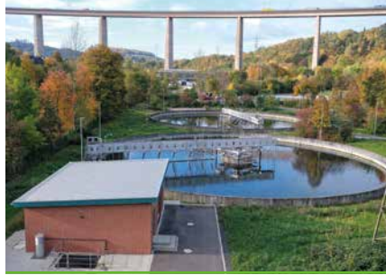
Im Vordergrund: neues Rücklaufschlammumpwerk (Tiefe ca. 5,50 m), im Hintergrund: die beiden ertüchtigten Nachklärbecken 1 und 2
