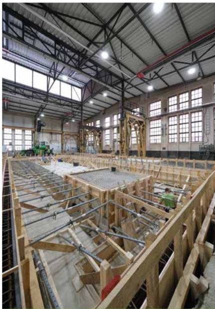
Aufwendige Schalarbeiten für das Fundament
