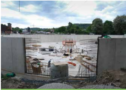
Blick in das fast fertiggestellte neue Nachklärbecken 3
