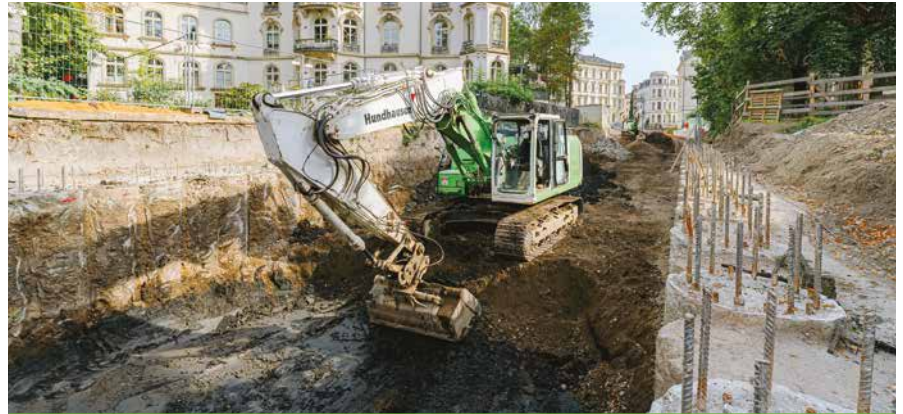
Baugrubenaushub und Freilegen der Bohrpfahlwand im Elstermühlgraben
