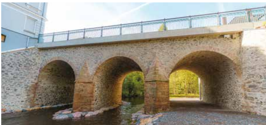
Die restaurierten 5,40 m hohen Rundbögen zeigen sich in frischer Pracht und im Einklang mit der Auma.
