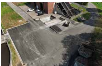
Drohnen-Aufnahme der Spülgutannahme mit der Erweiterungsfläche
