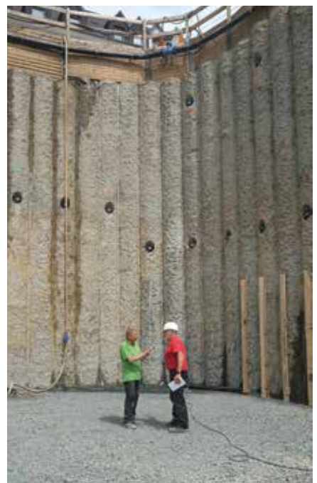
11 m tiefe Baugrube, hier entsteht die dritte Tiefgaragen-Ebene
