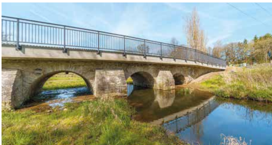
Das fertig sanierte Brücken-Bauwerk erstrahlt nun in neuem Glanz.
