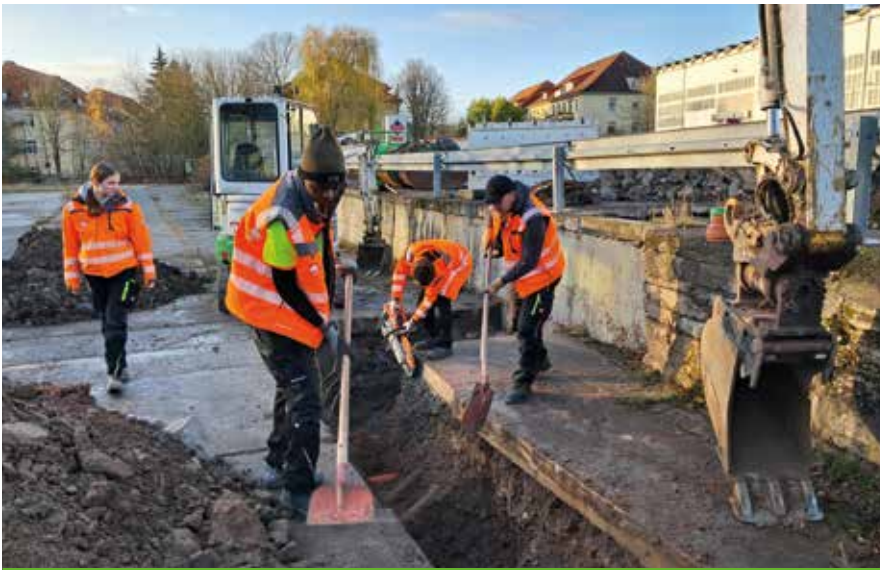
(v. l.) Alicia Scholl, Brachel Vergesse Zafack, Bastian Jacob und Shota Basanidze beim Säubern der Schnittkanten und Freischneiden der Stahlbewehrung, die im Untergrundbeton gefunden wurde.
