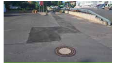
Die Baumaßnahme ist abgeschlossen und der Grabenverlauf asphaltiert.
