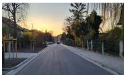
Die fertige Asphaltdecke bildet den Abschluss der Infrastruktur-Baumaßnahme
