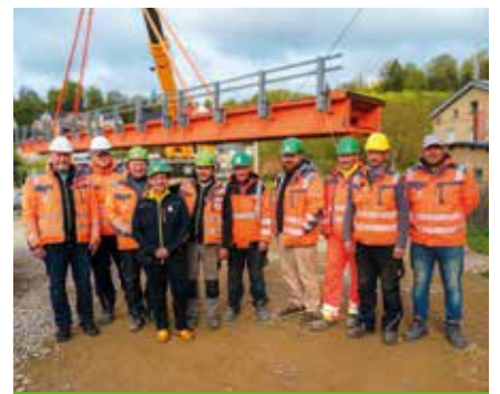
Das Hundhausen-Bauteam vor Ort: An diesem Tag wurde die Behelfsbrücke erfolgreich eingehoben.
