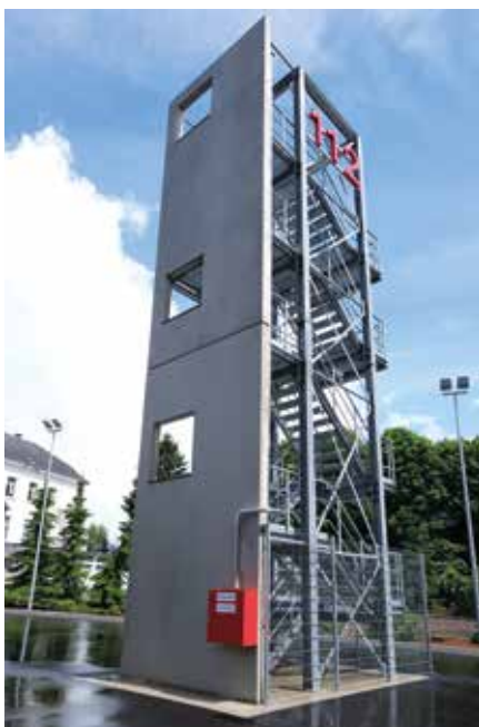
Freistehender Übungsturm mit Trockensteigleitung
