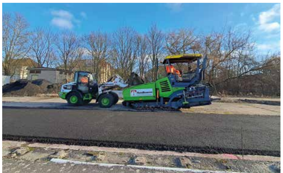
Beladung des Asphaltfertigers mit Fräsgut
