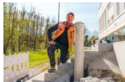
Ives Wagner ist sichtlich erfreut über die gelungene Sanierung.
