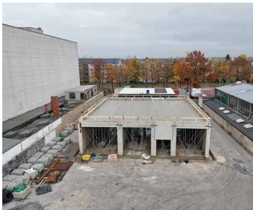
Blick auf den fertiggestellten Rohbau der Waschstraße
