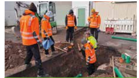
Polier Ralf Arnold erläutert den Einbau und die korrekte Kanalrohrverlegung.
