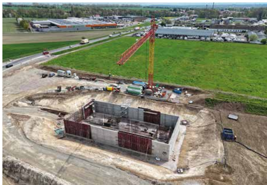
Blick in das 35 m lange Regenrückhaltebecken Nr. 13 während der Bauphase
