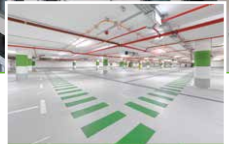
Eine der drei Tiefgaragen im zweiten Untergeschoss
