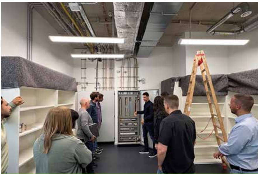
Erläuterung der Funktionsweise einer Gebäudeautomationsstation
