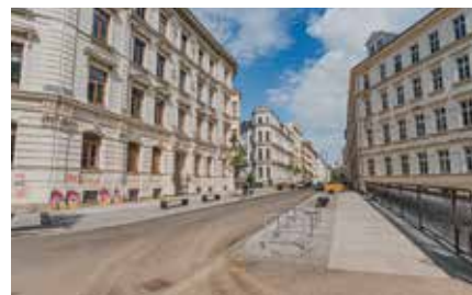
Straßenraum und der Gehwegbereich mit Fahrradbügel, Brückengeländer sowie Sitzbänken nach Fertigstellung der Poniatowskibrücke
