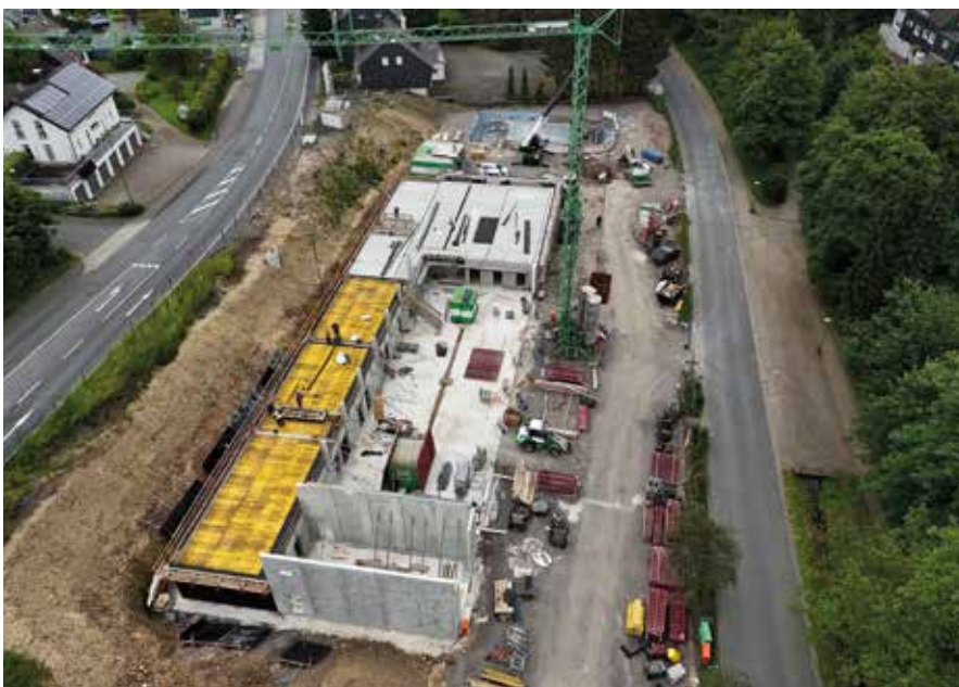
Die Drohnenaufnahme zeigt den Zeitpunkt der Fertigstellung des Erdgeschosses.
