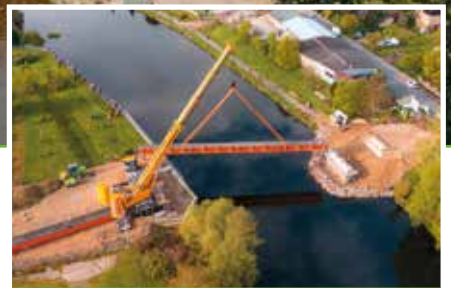
Die 52 m lange Behelfsbrücke
